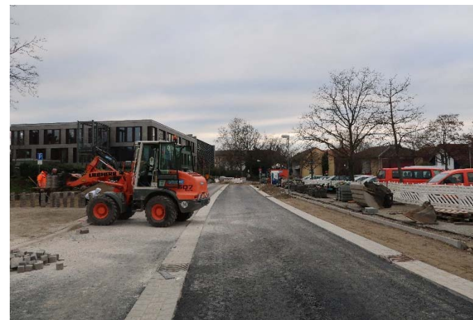
Sanierung Alte Poststraße
