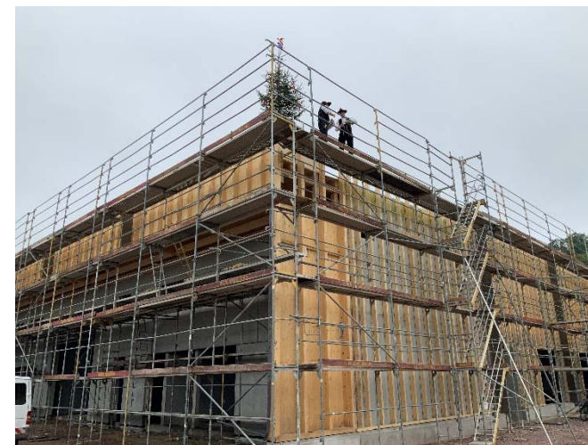
Richtfest am Betriebshof Kenzingen
